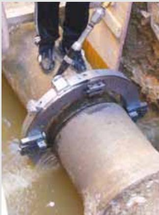
Il montaggio può essere eseguito infilando la macchina sul tubo, o anche aprendo in due mezze lune l'unità, e assemblandola attorno al tubo stesso.
